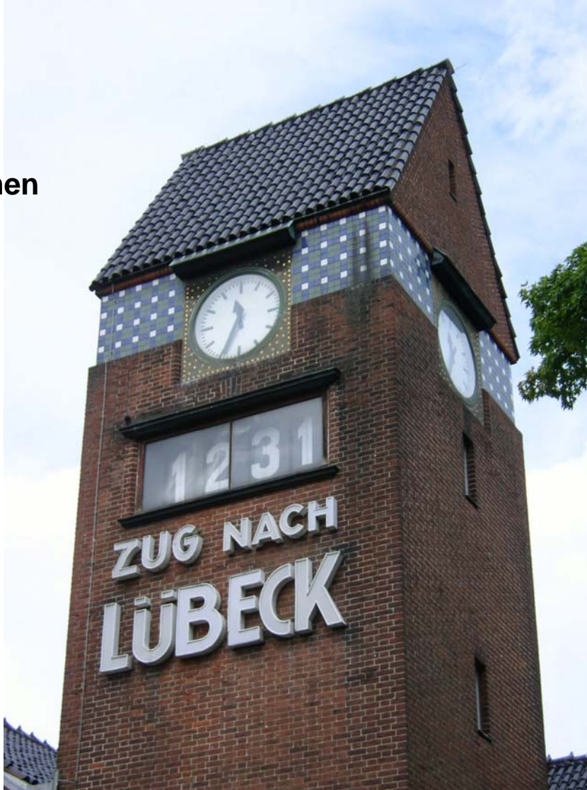
Der alte historische Strandbahnhof Travemünde von 1912 mit seiner übergroßen Anzeigentafel.
