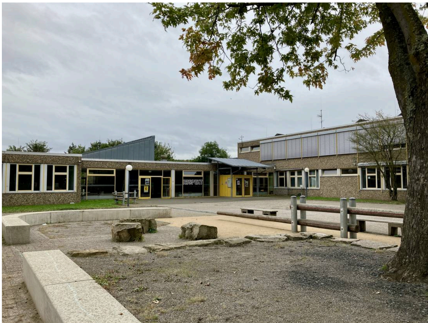
Zwei Räume der ehemaligen Realschule in Holzheim werden zu einem offenen Jugendtreff umfunktioniert.
